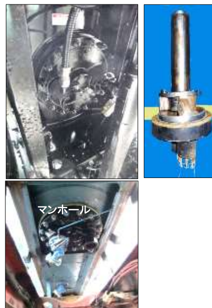
液中ポンプ(実際に設置されている状態)
