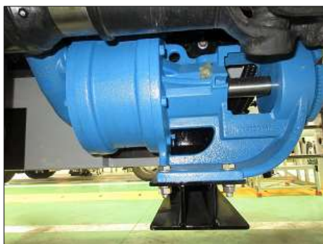
バイキングポンプ(実際に設置されている状態)
