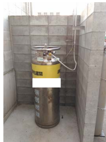
残液回収時の接続例 (写真の容器は断熱不良容器ではない)
