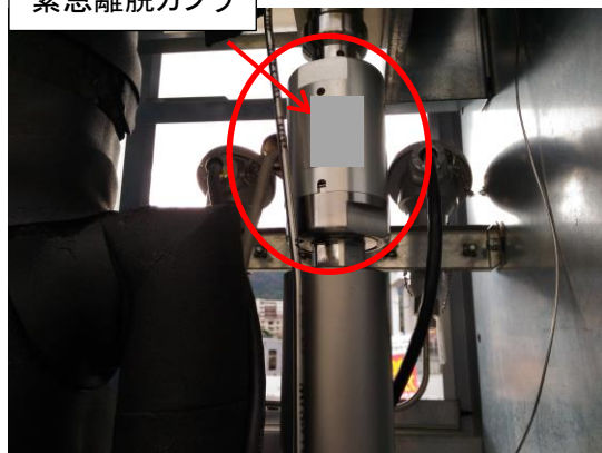
緊急離脱カプラ(交換後の様子)
