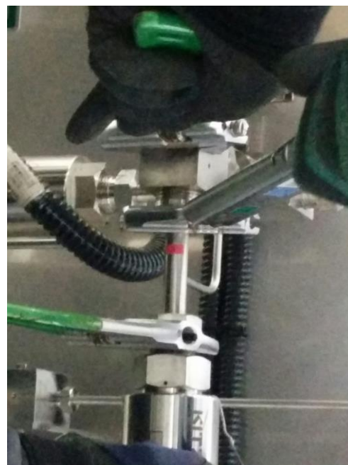
継手部の増し締めの様子(二人作業)
