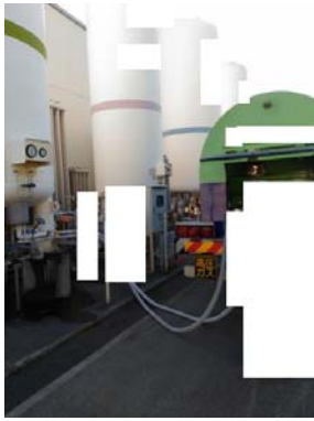
図 1. CE への充填の様子
