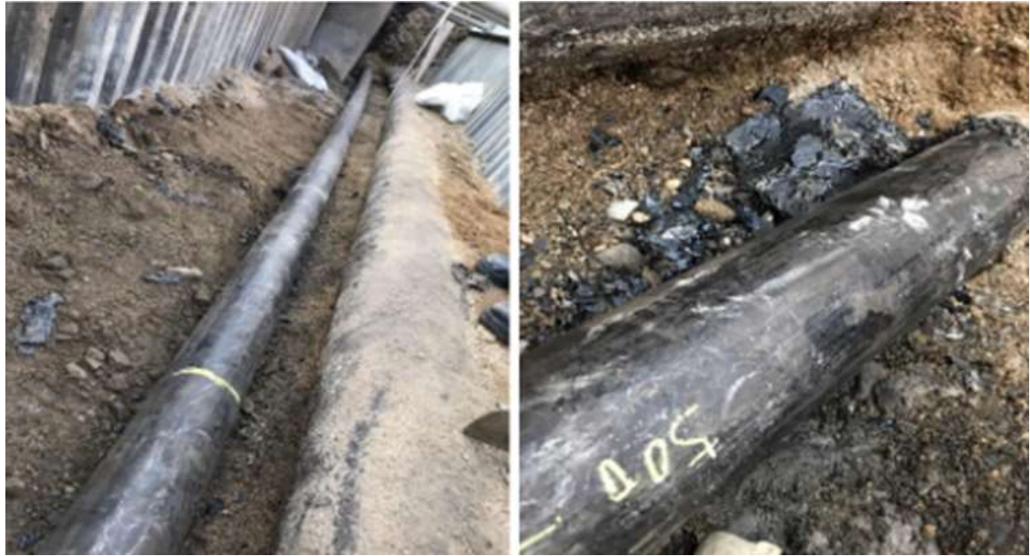
図3 漏えい箇所近傍のカルバート外の導管
