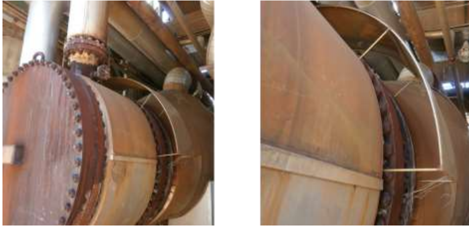
図 2 レインシールドの構造
