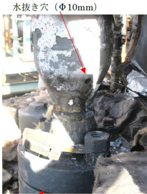
R/D 挿入箇所 図 7 高圧分離器に設けた破裂板の放出管の下部
