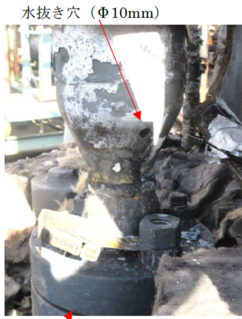
図 7 高圧分離器に設けた破裂板の放出管の下部
