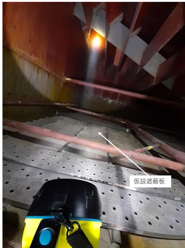
図 6 スモーク通過テスト後の仮設遮蔽板上部空間
