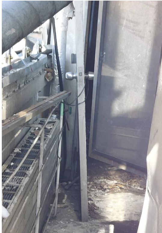
図 6 カセットボンベ充填室の南側の防火扉
