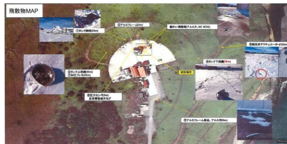
図 3 破裂したタンクの飛散状況
