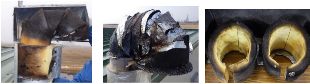
図 4 保温材の焼損状況
