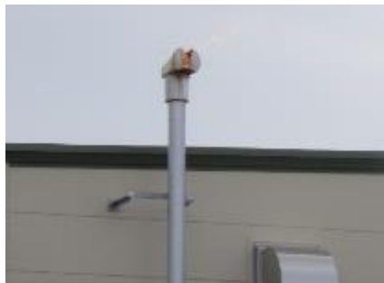
図3 水素の燃焼と保温外装板の破裂状況
