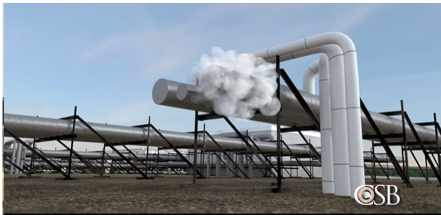
(図2) 施設内の配管からアンモニアが漏れ出す様子（CSB 映像からキャプチャー）
