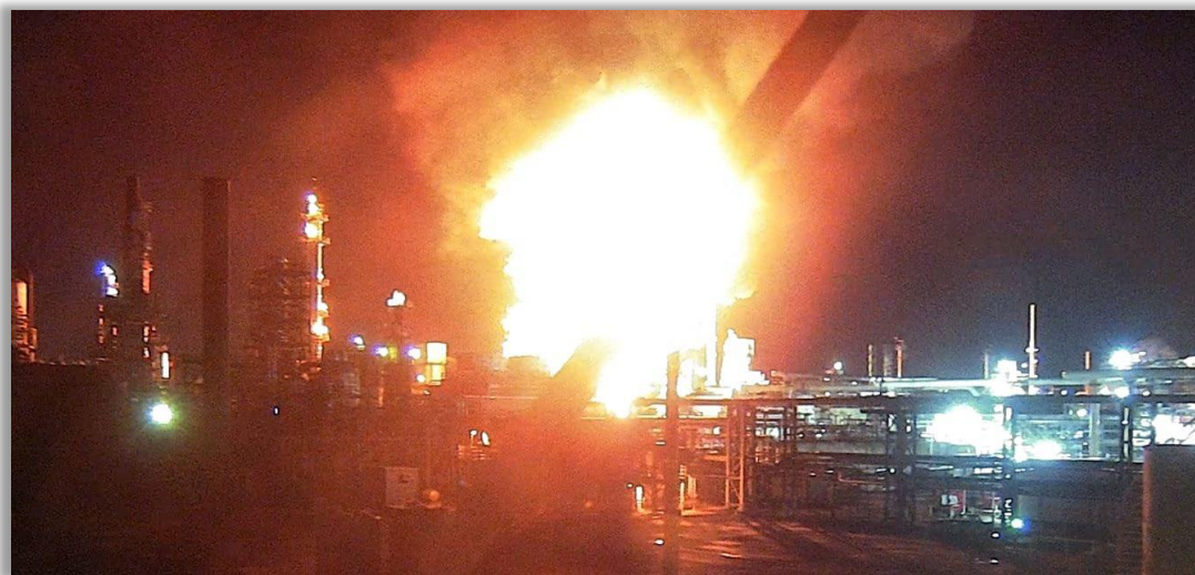
図1：加熱炉火災の監視カメラ映像（出典：マラソン社）
