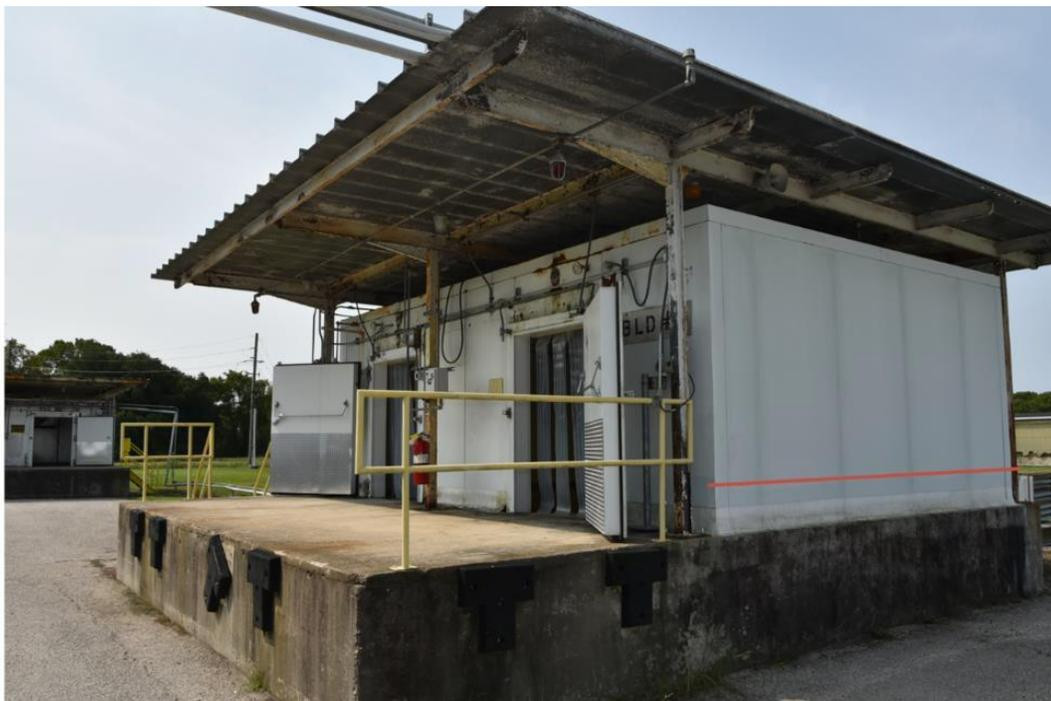
図29：アルケマ・クロスビー施設の低温倉庫。赤い線は、洪水の最高水位を示しており、地上から約5フィート（約1.5メートル）の高さに達していた。（出典：CSBの写真）
