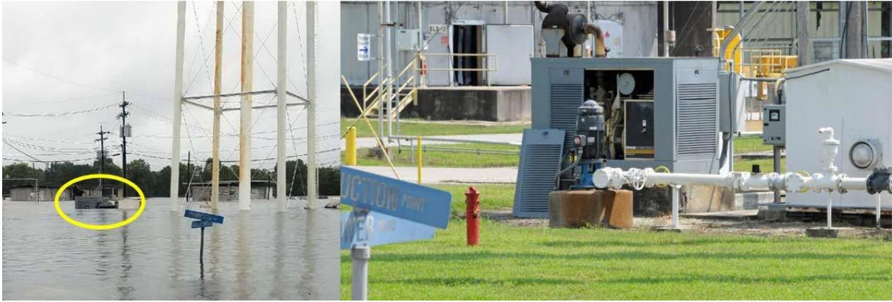
図19：低温倉庫にバックアップ電力を供給する非常用発電機。左の写真は、2017年8月29日（火）に洪水標高が発電機の下半分を覆った様子を示している（黄色の楕円部分）。右の写真は、事故後に撮影された同じ発電機の様子である。（出典：CSBが修正したアルケマ社の写真（左）、CSBの写真（右））
