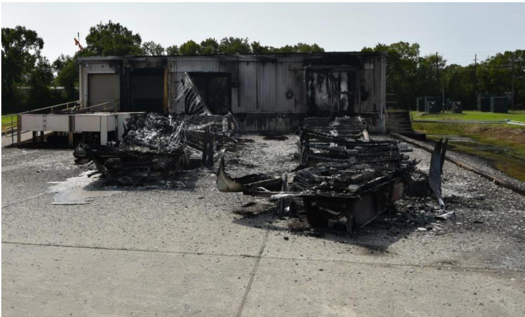
図41：有機過酸化物製品を保管する2台のトレーラーを焼失させた2度目の火災の残骸。2回目の火災で、有機過酸化物製品を保管する冷蔵トレーラー2台が焼失した後の画像。（出典：CSBの写真）
