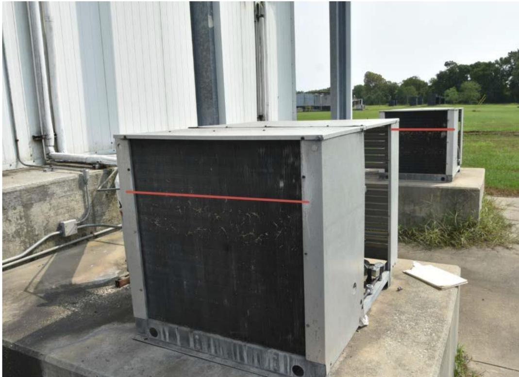
図17：低温倉庫の裏に設置された空調設備。空調設備に重ねて引かれた赤い線は、アルケマ・クロスビー施設の最終的な浸水水位を示している。（出典：CSBの写真）
