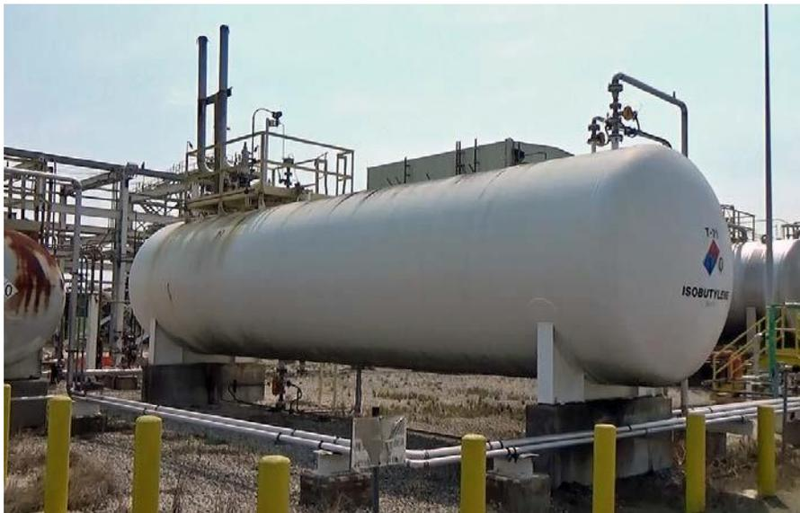
図59：アルケマ・クロスビー施設のイソブチレン貯蔵タンク。アルケマ・クロスビー施設のイソブチレン貯蔵タンクは、有機過酸化物品が入った最も近い冷蔵トレーラーから100フィート以上離れた場所にあった。（出典：CSBの写真）
