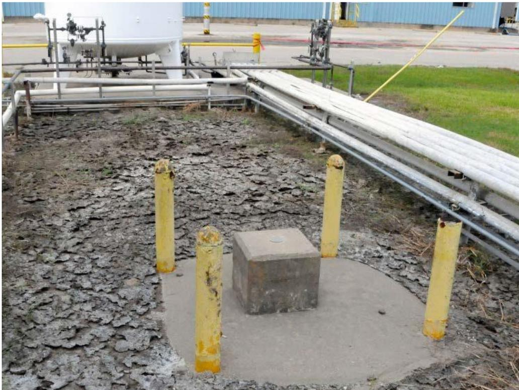
図55：液体窒素貯蔵タンク付近の標高測量標。コンクリートブロック上に設置された金属プレートには、標高が51.5フィートであり、基準洪水標高よりも約6インチ低いことを示している。ハリケーン・ハービーの際の洪水標高は、この測量標の高さより3フィート以上高かった。（出典：CSBの写真）
