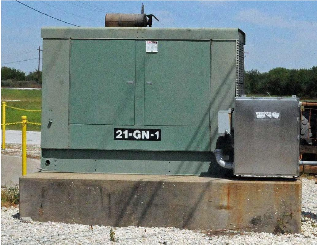
図5：アルケマ・クロスビー施設にある7台の非常用発電機のうち1台。発電機21-GN-1は、アルケマの7棟の低温倉庫に非常用電力を供給する2基の発電機うちの1基である。発電機の底部（コンクリート基礎の上部）は地面から約2フィート（約60cm）の高さにある。（出典：CSBの写真）
