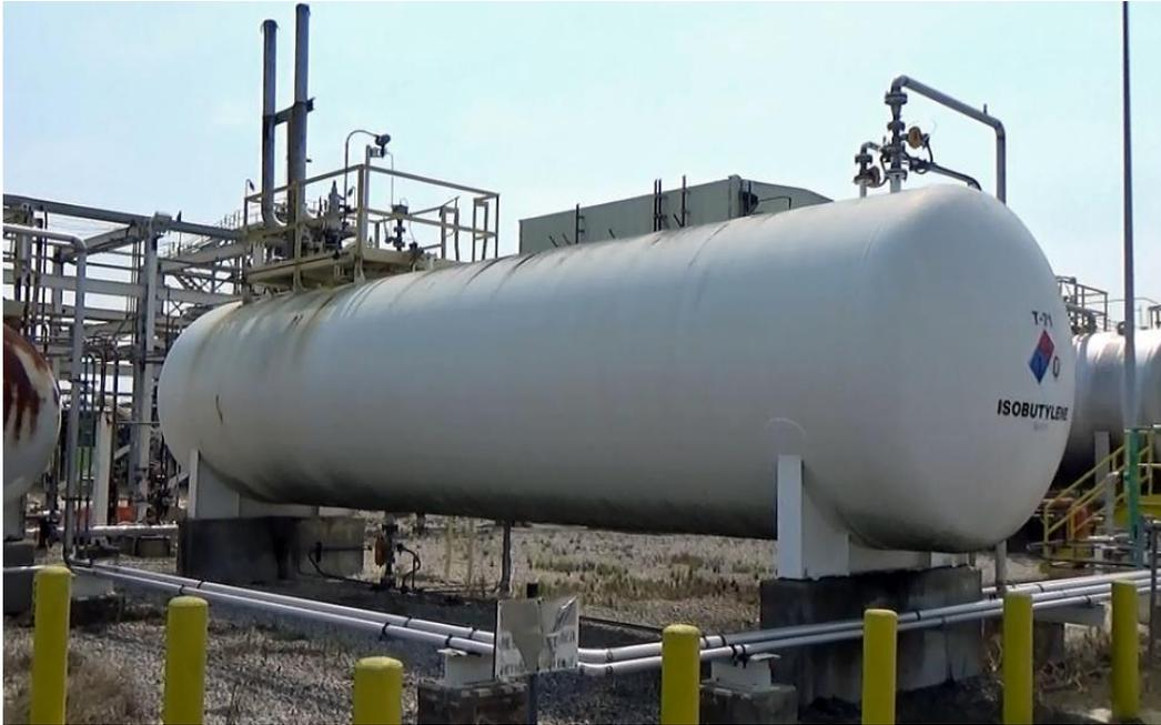
図43：アルケマ・クロスビー施設のイソブチレン貯蔵タンク。イソブチレン貯蔵タンクは、レイダウンエリア内で6台の冷蔵トレーラーの管理燃焼が実施される場所から約40ヤードの距離にあり、安全性への懸念があった。（出典：CSBの写真）
