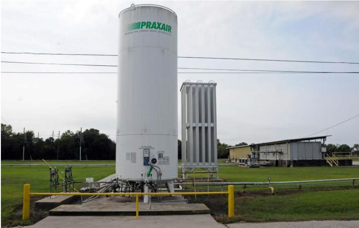
図6：アルケマ・クロスビー施設の液体窒素タンク。このタンクには最大40,000ポンド（約18トン）の液体窒素が貯蔵されており、有機過酸化物の低温倉庫に注入することでバックアップ用の冷却源とすることができる。（出典：CSBの写真）
