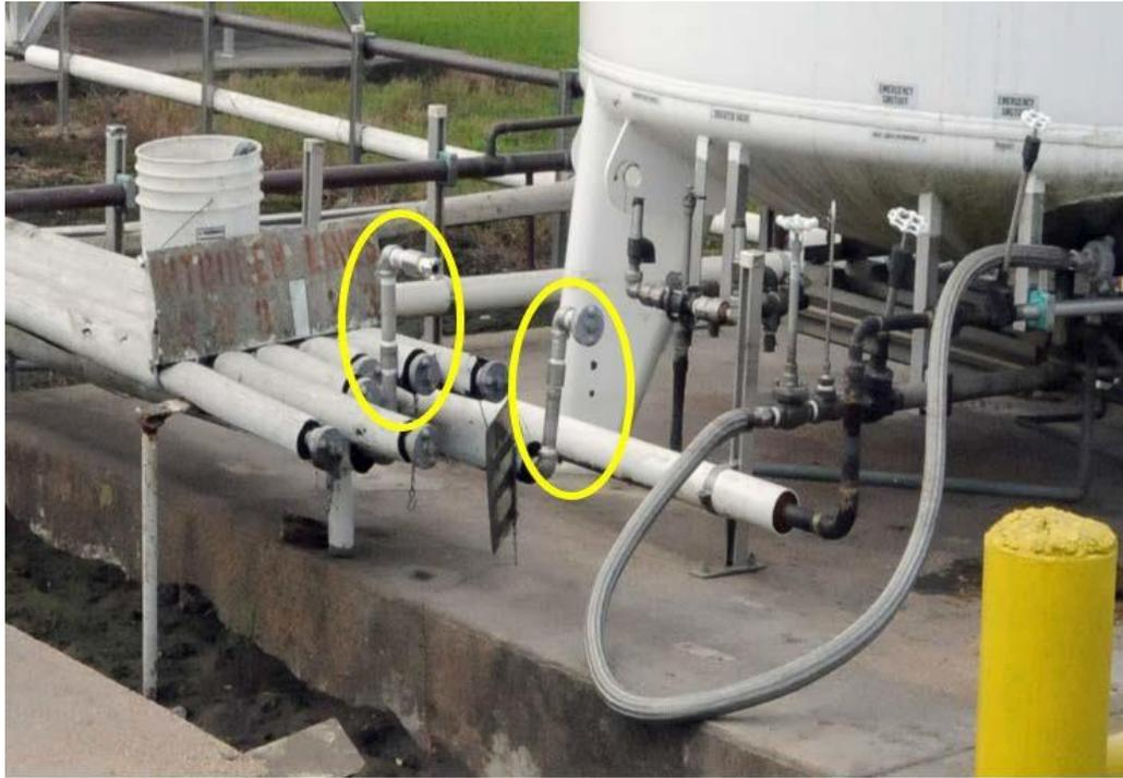
図20：液体窒素配管の延長。工場監督者は、有機過酸化物品が保管されている低温倉庫に現場対応チームが液体窒素を注入する必要がある場合に備え、接続ポイントが洪水標高より上に維持されるよう液体窒素の配管を延長した。しかし、この延長された接続部も十分な高さではなく、水位のさらなる上昇により最終的には浸水してしまった。（出典：CSBの写真）
