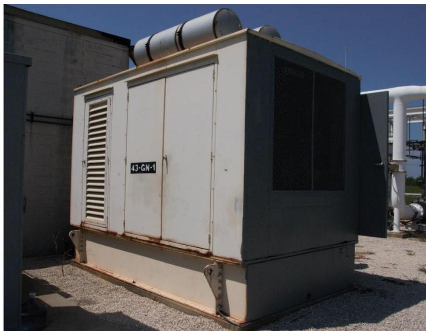
図25：非常用発電機。これは、アルケマ・クロスビー施設の停電時に自動的に作動する非常用発電機の一つである。（出典：CSBの写真）
