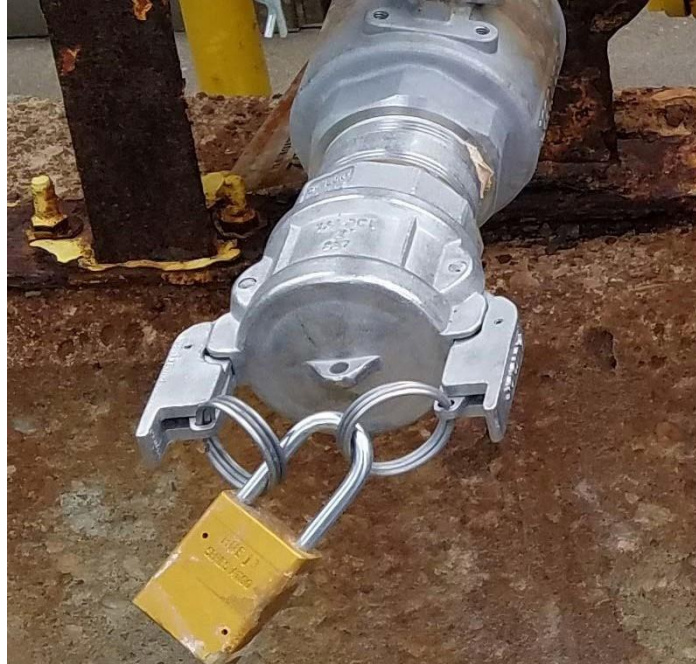
図5：Mod Bの充填ライン末端にある施錠されたカムレバーダストキャップ（出典：CSB）
