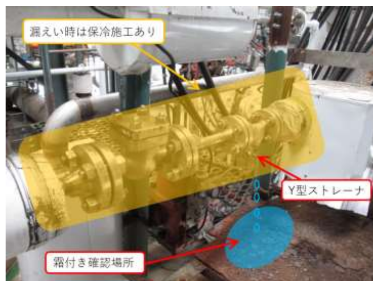
図1 事故発生後の合成ゴム製造施設の触媒配管付近
