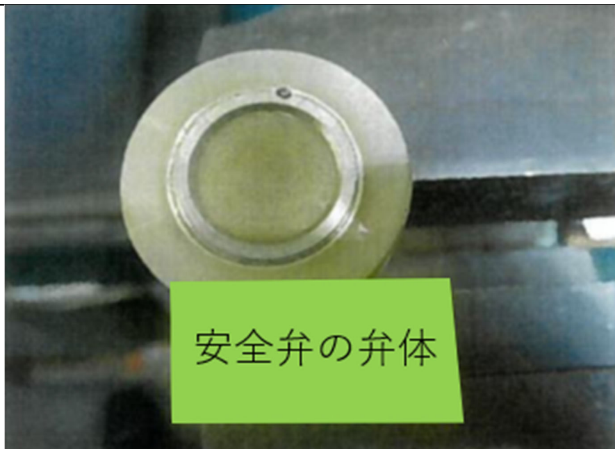
図 3 スケール噛み込みによる安全弁の弁体シートの傷
