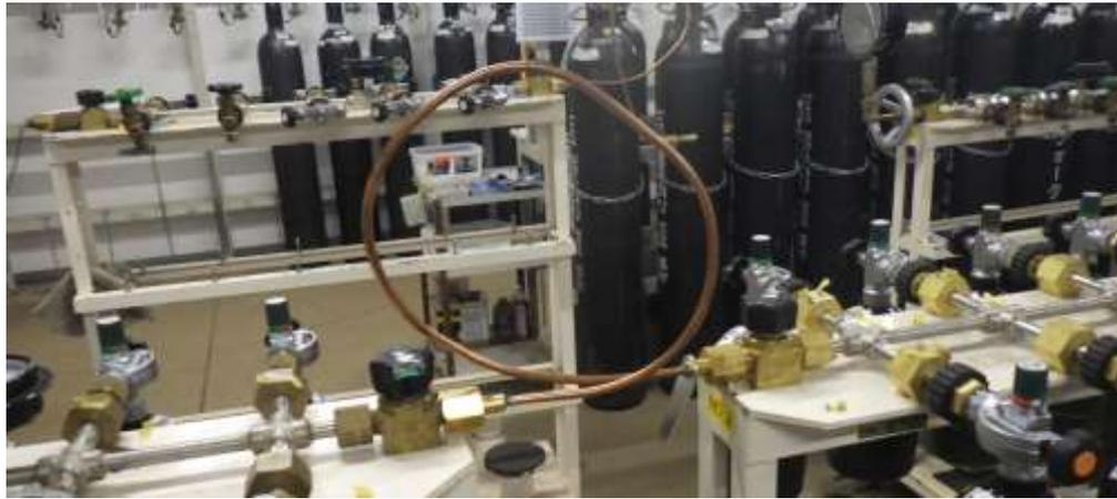
図 8 設備改修(銅配管に変更)
