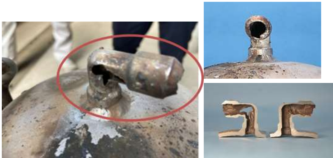
図7 事故後のポンプの状況(内槽の底部のエルボ)
