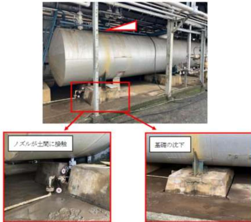
図3 脱圧槽沈下状況(事業所提供)
