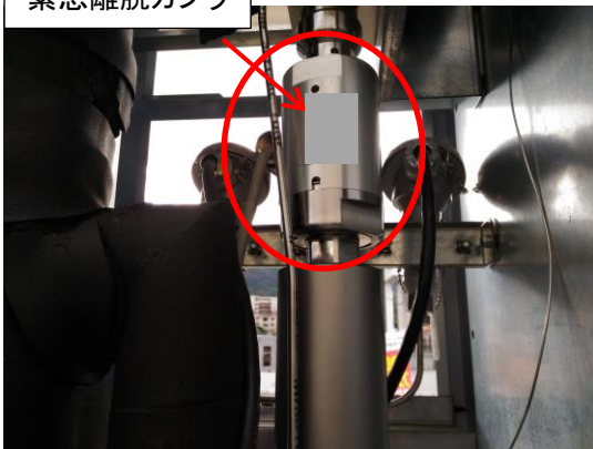
緊急離脱カプラ(交換後の様子)
