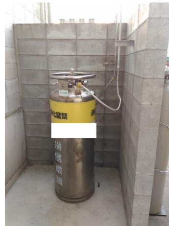
残液回収時の接続例
