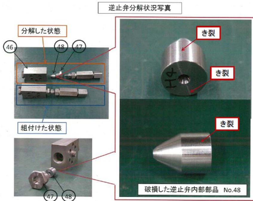
図2 破損した逆止弁
