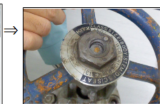
ナットを緩めて さらに閉止方向に回す
