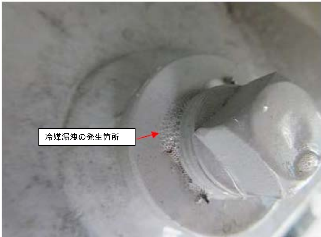
写真 2 受液器テーパプラグのねじ込み部からの冷媒の漏えい状況
