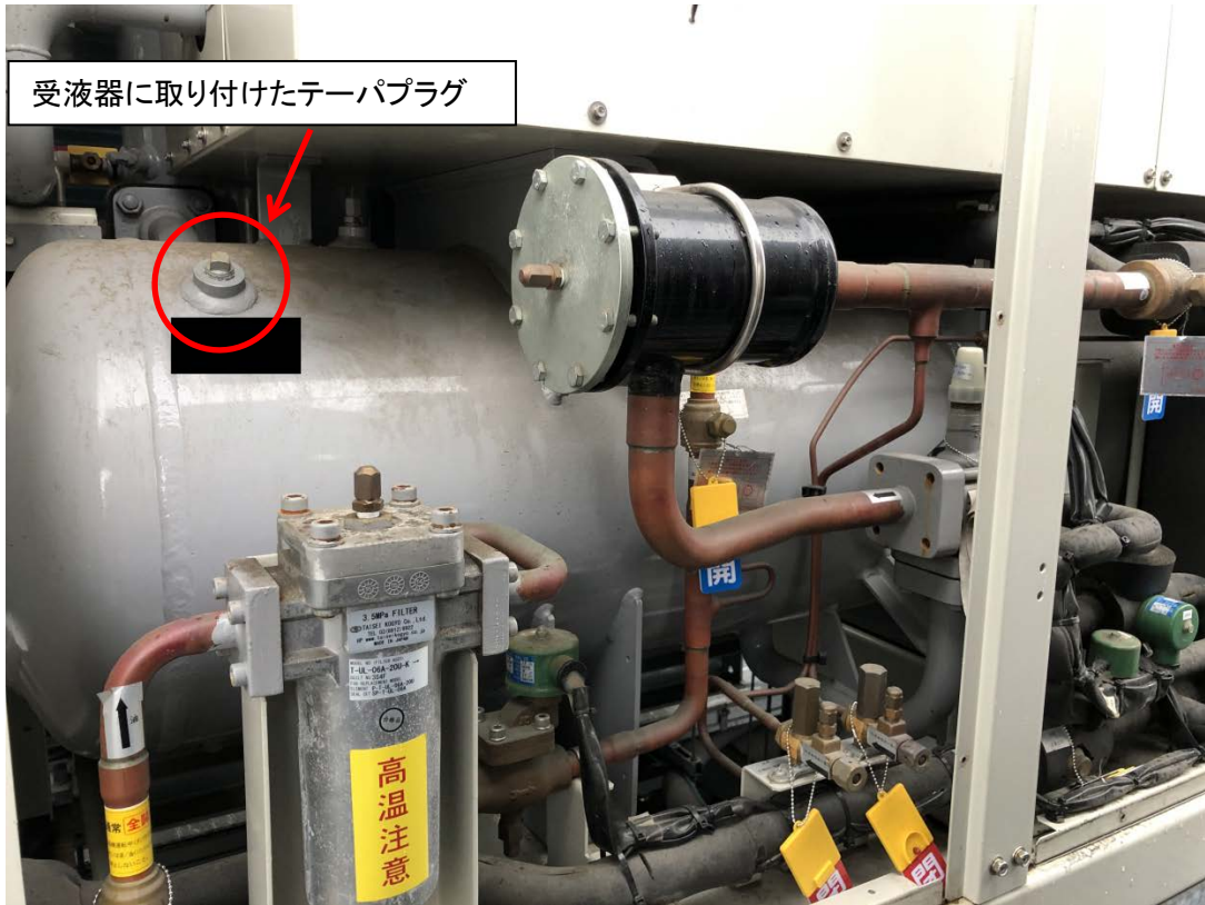
写真 1 冷凍機ユニット内受液器の設置状況
