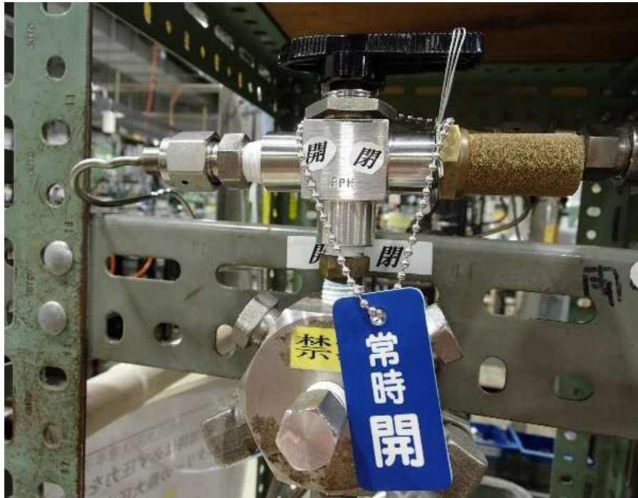
図 6 三方弁の固定方法(ハンドルを針金で固定)
