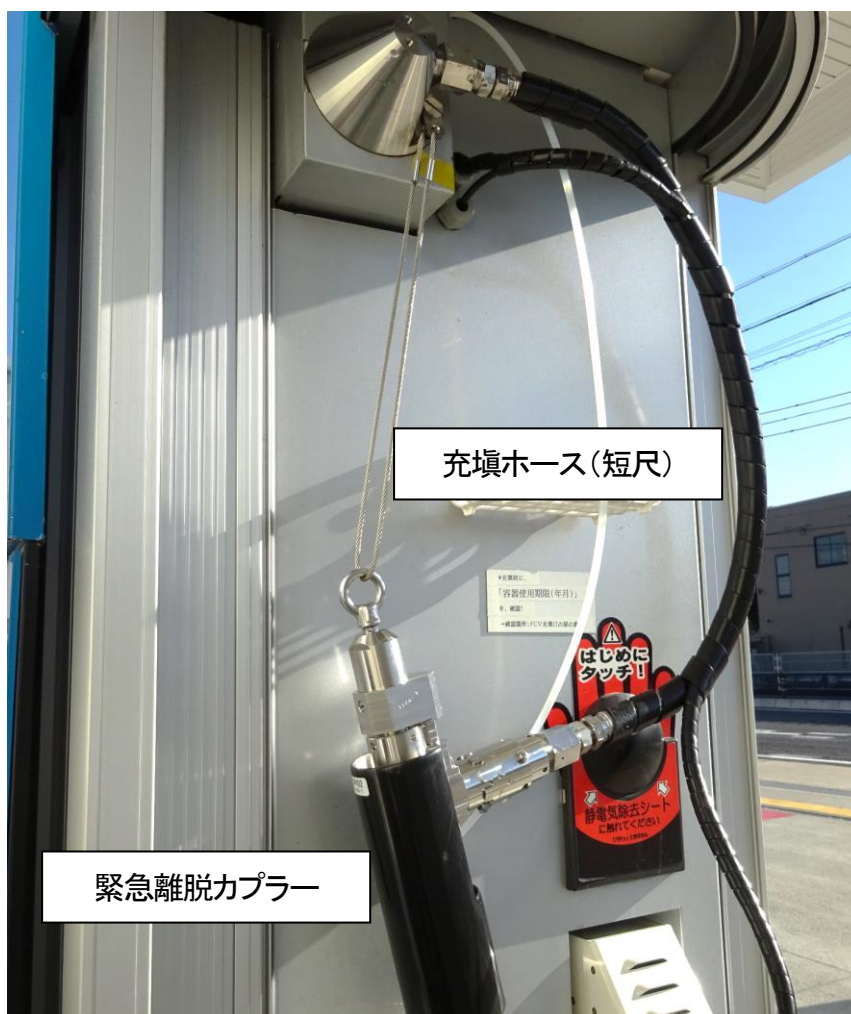
図2 ディスペンサーの短尺充填ホース (事故後に撮影)
