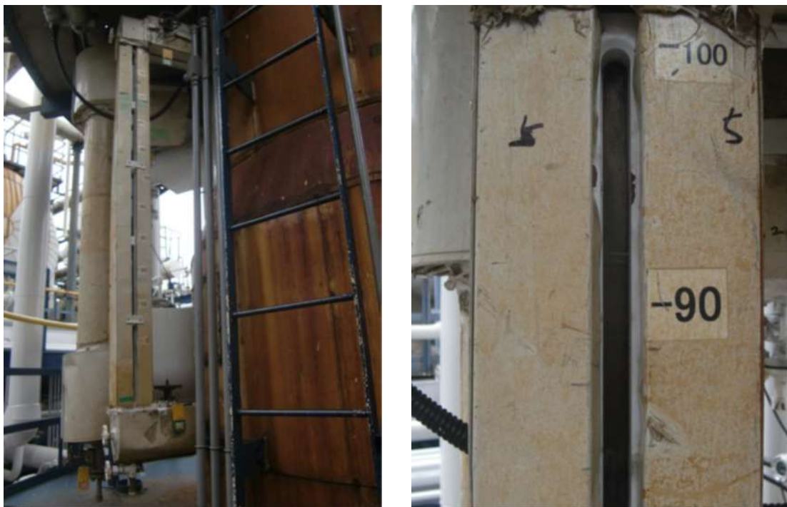
図 3 直視式液面計の液位
