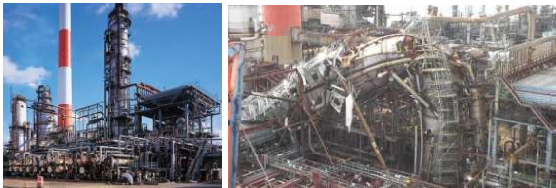
図 1 倒壊した主蒸留塔 (左:火災事故前、右:火災事故後)
