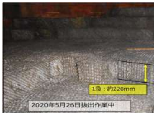
図5 ディストリビューターを撤去してパッキング搬出作業中の塔内の状況
