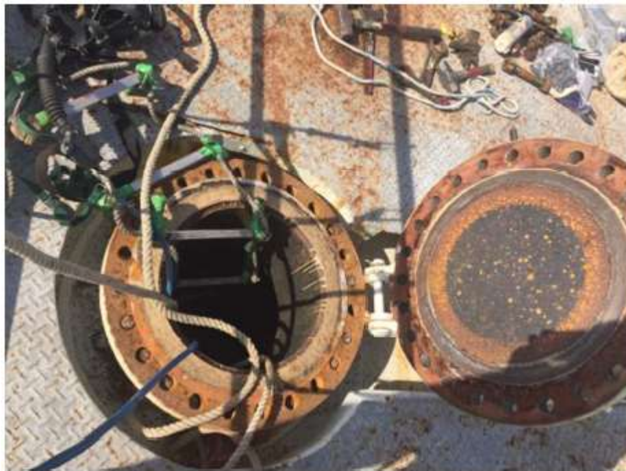
図 2 事故発生時の横置き円筒形貯槽上部のマンホールの状態 （マンホール開放、縄梯子取付け）
