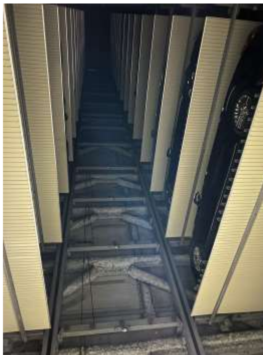
図2 立体駐車場内部
