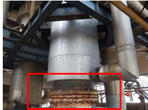
図2 漏洩箇所整備後
