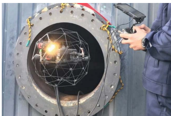
危険物タンクの点検孔に入る様子
