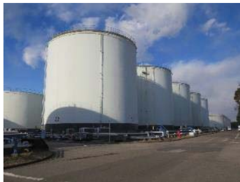
実証対象となるタンク
