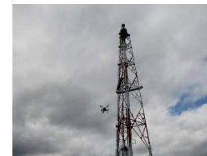
← フレアースタック (活用事例集より引用)
