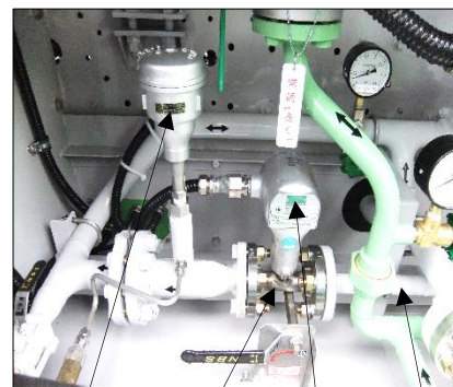
流量計本体 整流管 測温抵抗体 発信装置
