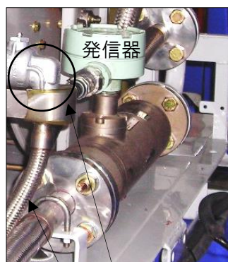
発信器 スイベルジョイント フレキシブルチューブ
