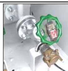
Y型弁の開閉表示
