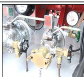
ボール弁の開閉表示
