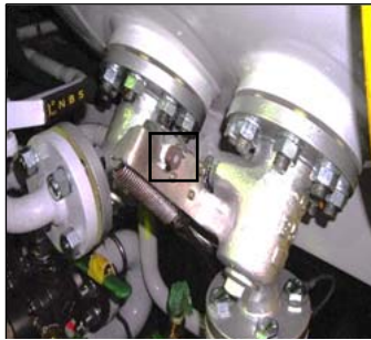
緊急遮断弁のヒューズメタル
