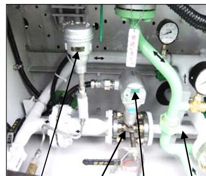
測温抵抗体 流量計本体 発信装置 整流管
