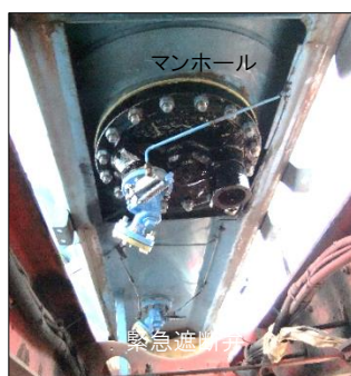
液中ポンプ(実際に設置されている状態)
