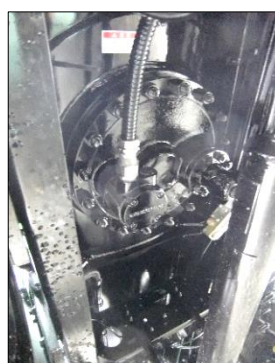
液中ポンプ(実際に設置されている状態)
