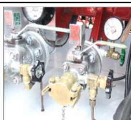
ボール弁の開閉表示 (ハンドルが開閉表示が固定されているのでハンドルを操作することで開閉が自動的に表示される。)
