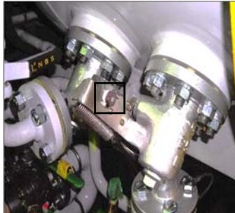
緊急遮断弁のヒューズメタル
