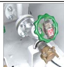
Y型弁の開閉表示 (ハンドルが逆さまになることで表示が反転する構造) ※ハンドルは何回も回転するので取扱い上では作業者が反転を確認すること。
