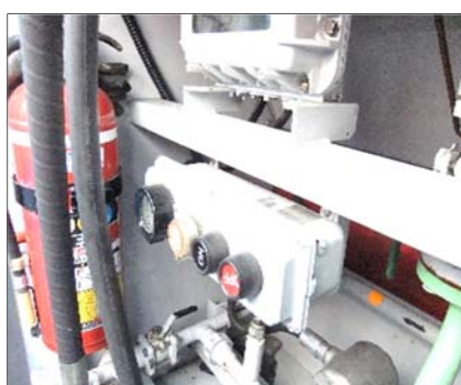
コントロールボックスのランプ・スイッチ
