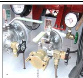
ボール弁の開閉表示 (ハンドルが開閉表示が固定されているのでハンドルを操作することで開閉が自動的に表示される。)
