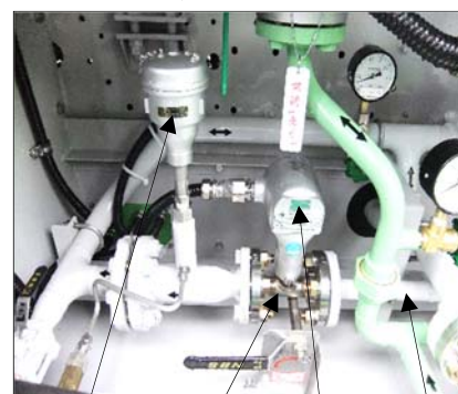
流量計本体 測温抵抗体 発信装置 整流管
