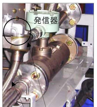
発信器 スイベルジョイント フレキシブルチューブ
