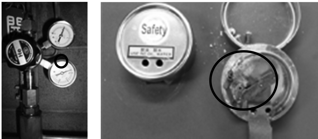
写真3 圧力表示器（左：交換前外観，右：交換後表示器内部）
