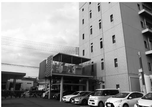
写真2 本社ビル非常用発電設備
