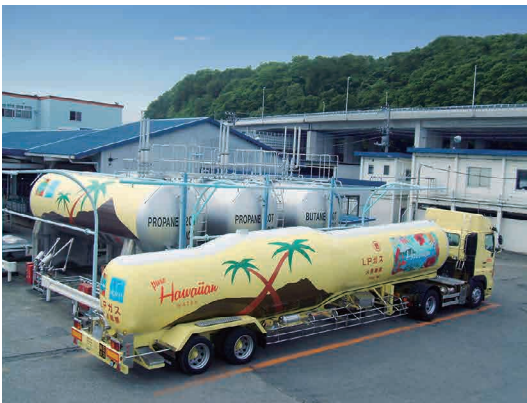
厚木工場外観（受入中16tタンクローリ）
