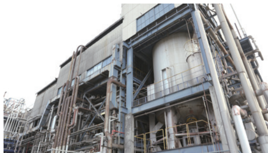
写真2 プラント外観
