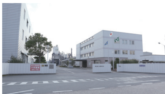
写真1 徳山積水工業(株)外観
