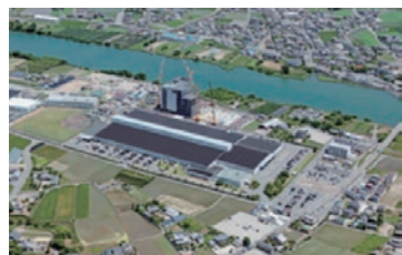
鳴門工場（N工場）
