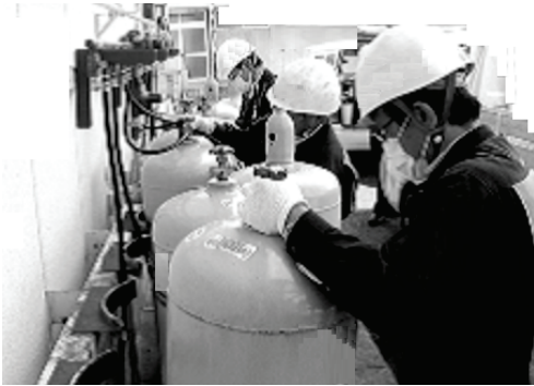
避難所にLPガス供給設備を設置
