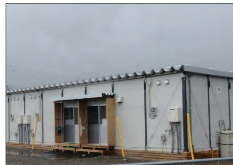
仮設住宅の建設
