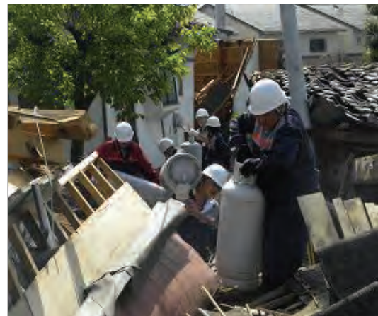
瓦礫の中から LP ガス容器を撤去
