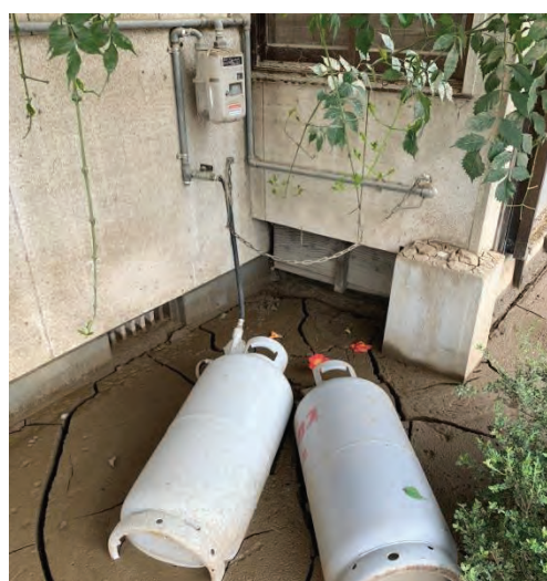
どちらのケースにおいても、容器が水に浮き、一重掛けの鎖から脱落している
