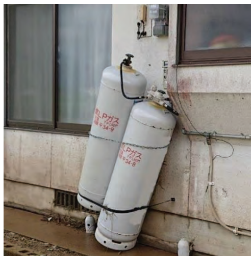
2重掛けを行った容器は水流の影響を受け ても流出することがなかった
