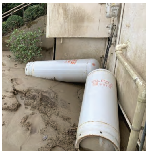
どちらのケースにおいても、容器が水に浮き、一重掛けの鎖から脱落している
