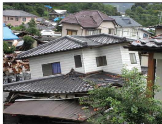
倒壊した住宅（益城町）
