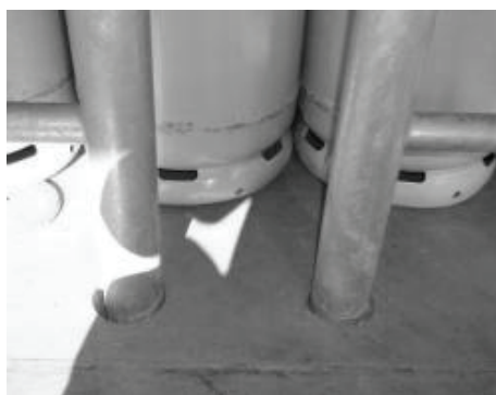
プラットフォームの床面に穴をあける
