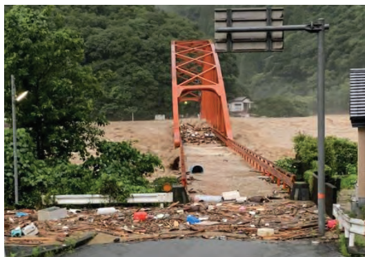
人吉市を抜けた球磨川の 狭窄部 で急速に水位が上昇し、濁流で深水橋も流された
