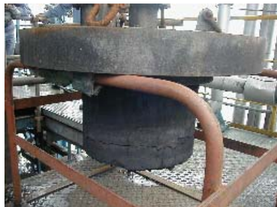
図4：マンホールのふた
