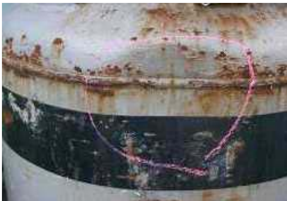
転倒による外槽上部円周の陥没 （発災容器とは別の容器）
