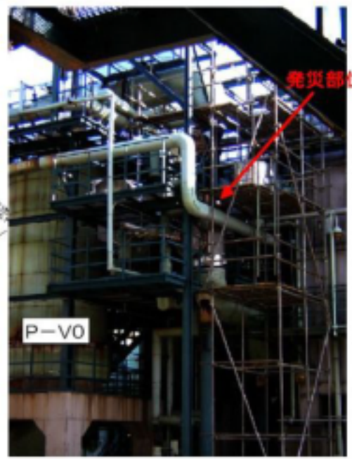
発災後、北西方向から撮影
