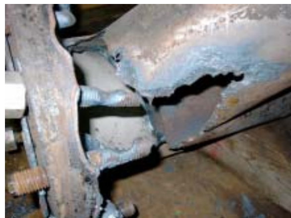
図5 フランジ付近の状況
