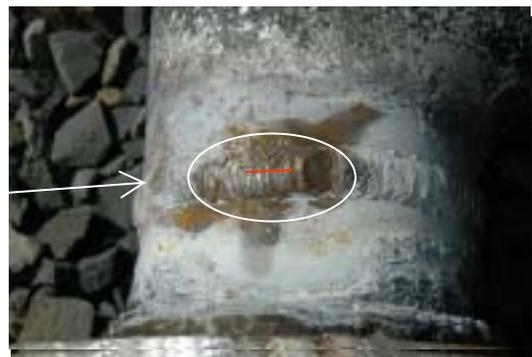
写真2 安全弁取出し配管の割れ部
