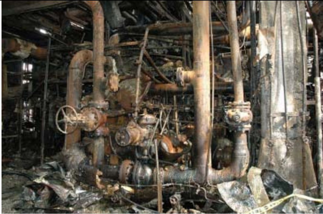
写真 5 減圧軽油脱硫装置の配管類の状況
