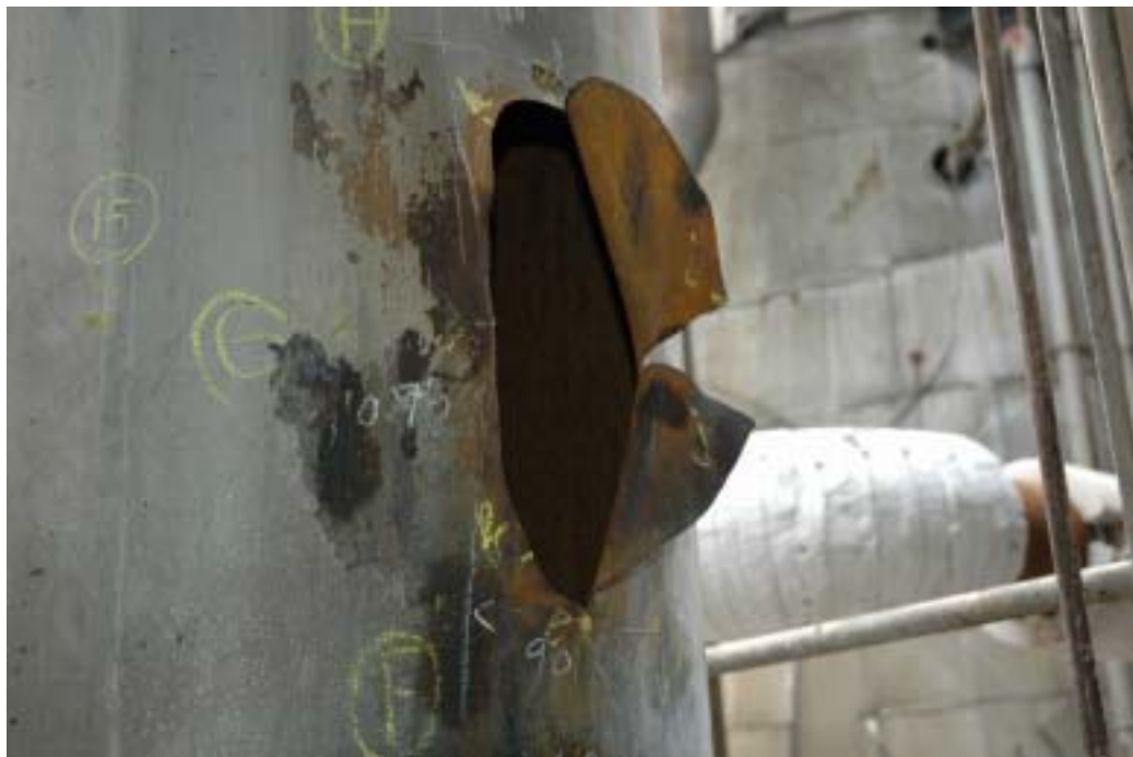
写真4 開口部の状況
