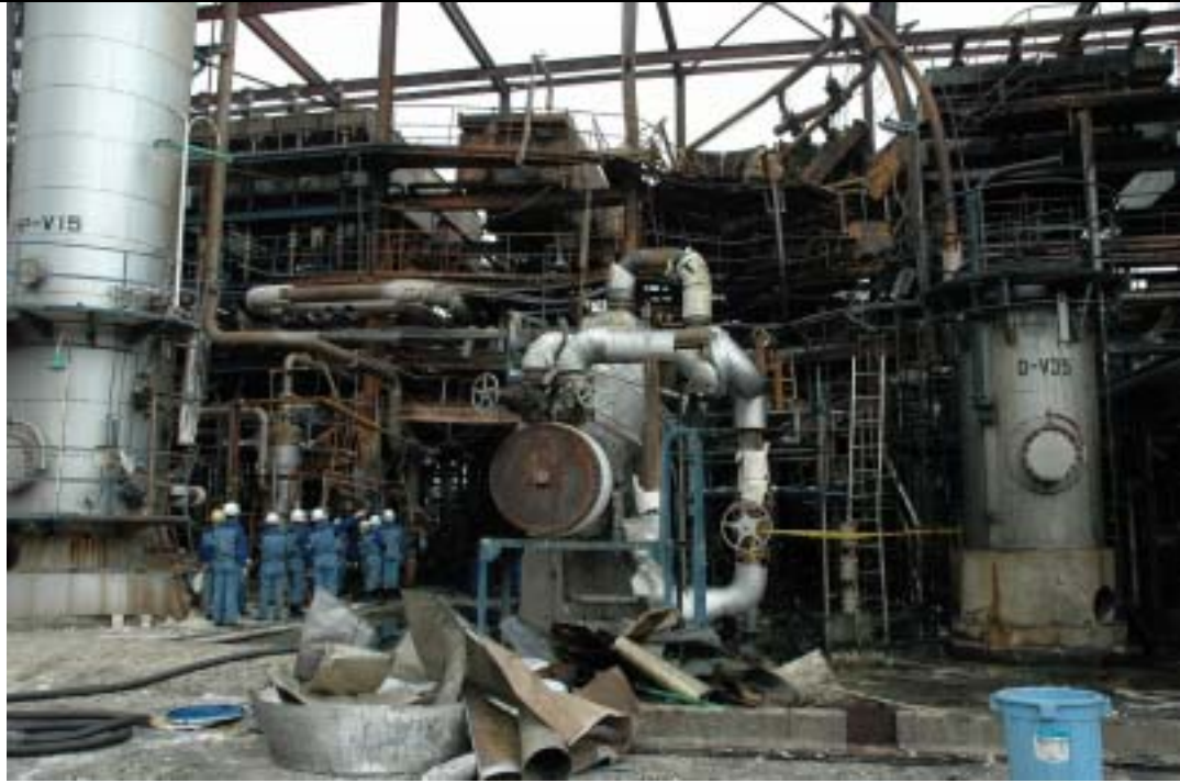
写真1 事故後の状況(炭酸ガス吸収塔(HP-V15)の右隣りが開口したセパレータ)
